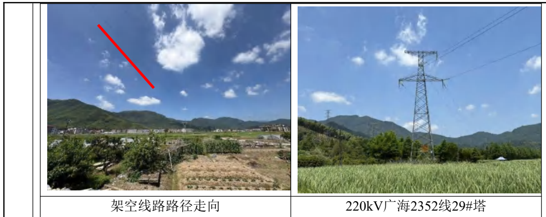
图 3-1 线路沿线环境现状
